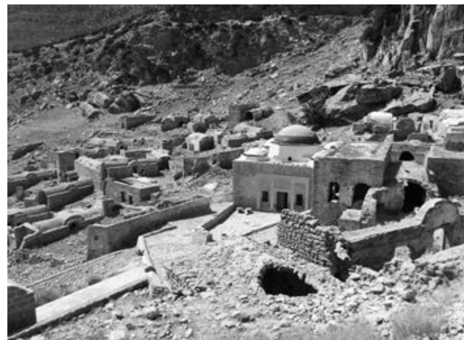
Fig. 1. Vista generale del villaggio di Zriba el-Alia
